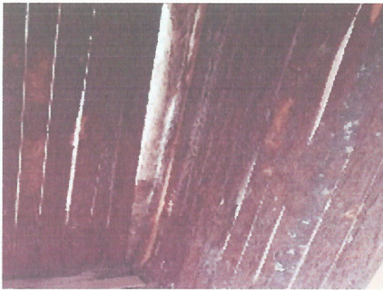
Foto 3: CAMBIO DE MADERA POR BLOCK
