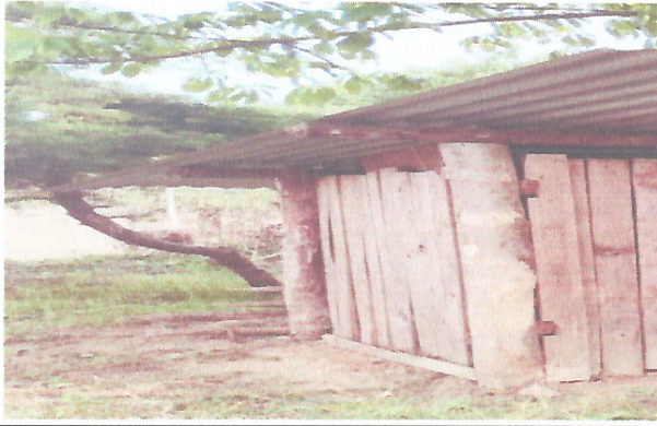
Foto 1: MEJORAMIENTO DE MODULO DE LAVAMANOS
