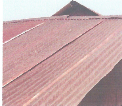
Foto 4: CAMBIO DE LAMINAS TROQUELADAS DE SANITARIOS Y LAVAMANOS
