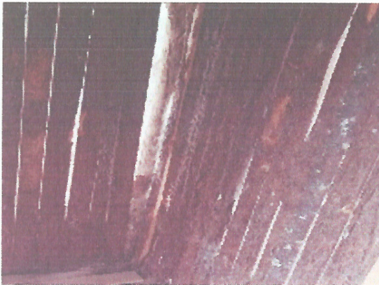
Foto 3: CAMBIO DE MADERA POR BLOCK DE SANITARIOS Y LAVAMANOS
