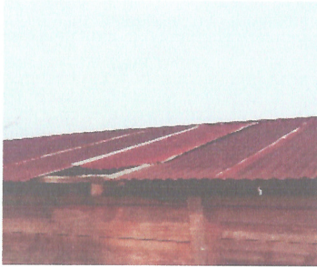
Foto 1: MEJORAMIENTO DE MODULO DE COCINA
