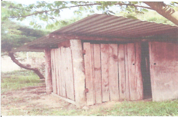
Foto 1: MEJORAMIENTO DE MODULO DE SANITARIOS Y LAVAMANOS
