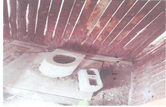
Foto 2: MEJORAMIENTO DE MODULO DE SANITARIOS Y LAVAMANOS
